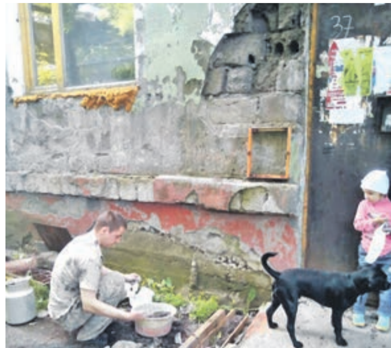
Жильцы сами берутся за ремонт.
